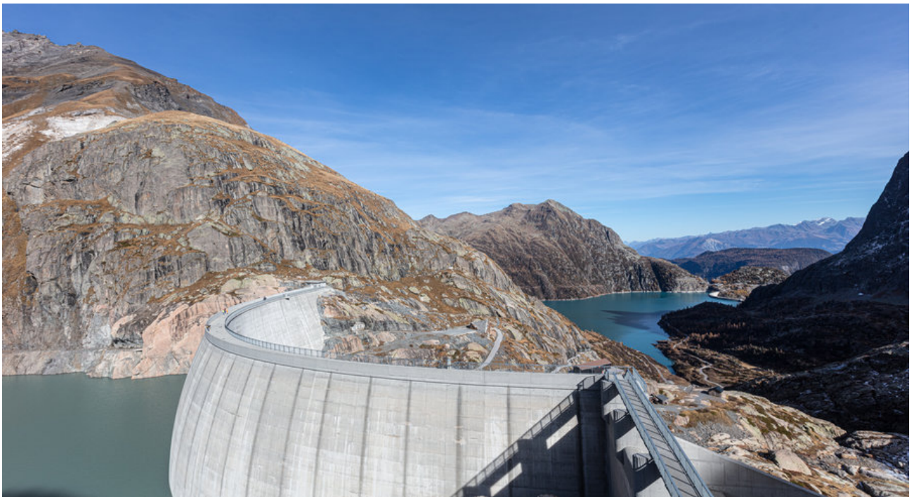
L'eau du lac du Vieux Emosson, retenue par un barrage, est entraînée vers une usine souterraine, celle de Nant de Drance, avant d'être propulsée dans le lac d'en bas, celui d'Emosson. Quand la centrale pompe, l'eau fait le chemin inverse. — © Thierry Sermier pour Le Temps
