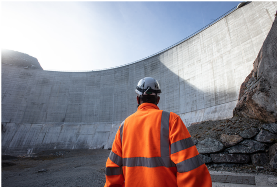
Alain Sauthier, directeur de Nant de Drance SA, face au barrage du Vieux Emosson: «En cinq minutes, on peut démarrer les turbines et passer d'une puissance de 0 à 900 MW.» — Thierry Sermier pour Le Temps
