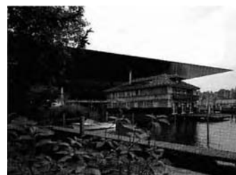
Jean-Michel Landecy, photographe, Genève : vue du Centre de culture et de congrès de Lucerne, Architectures Jean Nouvel, Paris, 1992-1998 (1 re étape).
