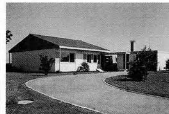
Maison familiale du directeur de la fabrique de Fontainemelon, réalisée avec des éléments préfabriqués issus de l'usine Igéco.
