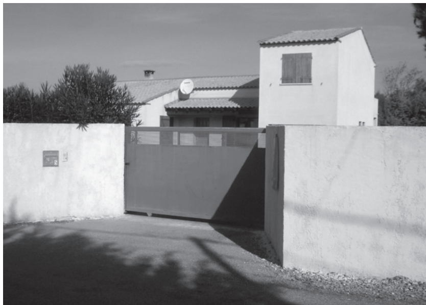
Fig. 8.3 Aménagement d'une pièce de survie : Les Garrigots, Cuxac d'Aude – 2002.
