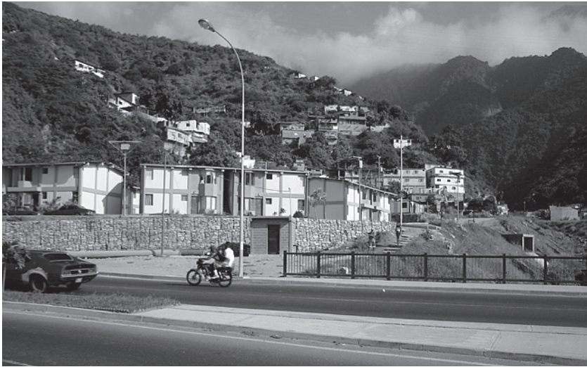
Fig. 10.3 Le quartier de La Veguita reconstruit, mai 2006 (photographie © Rogelio Altez).
