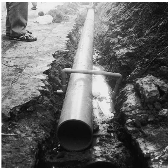
Fig. 8.4 Pose d'une nouvelle canalisation d'évacuation des eaux.
