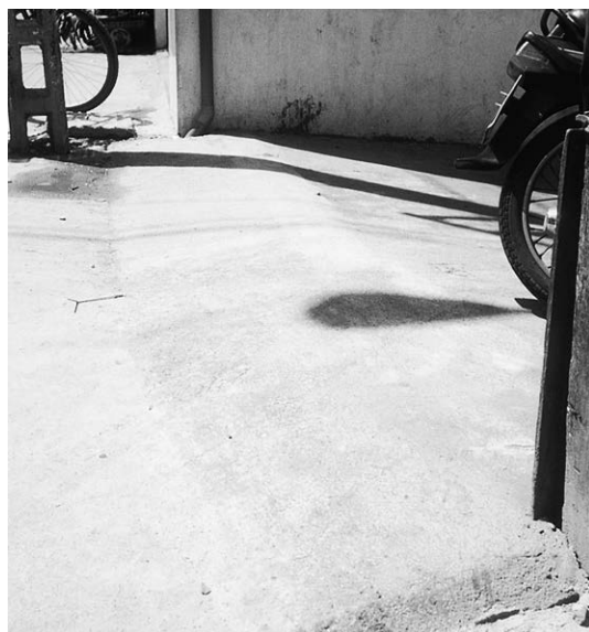
Fig. 8.5 Seuil à l'embranchement d'une ruelle
