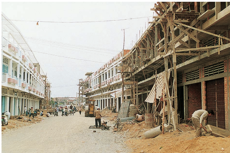
Le chantier des nouveaux quartiers
