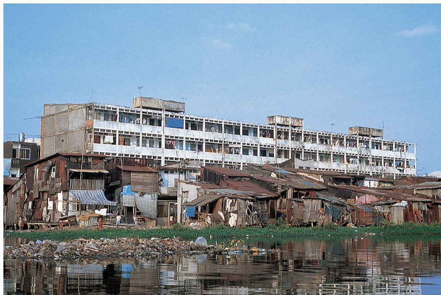
Locatifs de relogement au-dessus du bidonville
