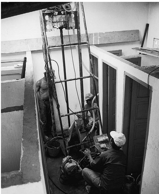
Fig. 8.2 Réalisation d'un forage dans des toilettes publiques.
