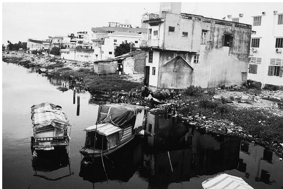
Fig. 7.8 Berges du canal Nieu Loc-Thi Nghe après évacuation de la bande riveraine (depuis le pont Dien Bien Phu, novembre 1996).
