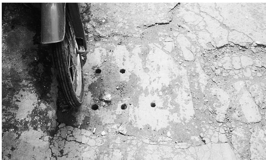
Fig. 7.1 Grille d'évacuation des eaux.
