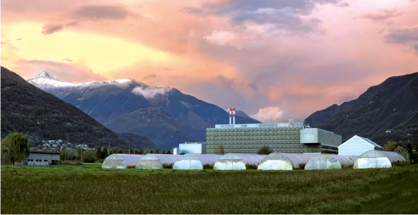
Abbildung 1 Das vierte Schloss, die Kehrrichtverbrennungsanlage in Giubasco, Fotografie: Mirko Menghetti.
