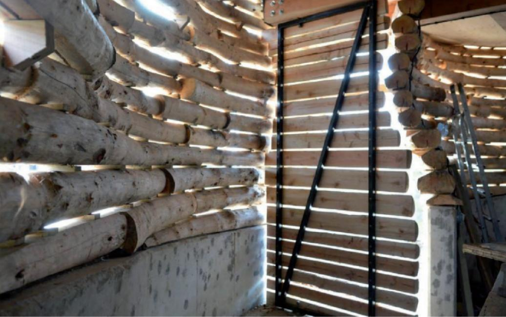
Le Biomass Boiler House à Hooke Park est un projet de Sattaveesa Sahu et Yingzu Wang qui utilise des techniques de scannage au laser et de l'architecture computationnelle afin de créer des murs en bois brut irrégulier.
