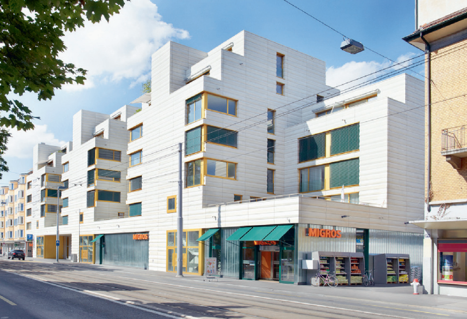
Wohn- und Geschäftshaus Badenerstrasse, Zurich, pool Architekten, 2006 (concours), 2008-2010 © Giuseppe Micciché
