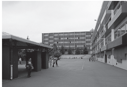
Lycée Romain Rolland – Ivry arch. Marcel Lods. Transformation par Guy Bourrier arch. – 2001
