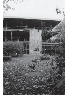
Siège de Saint-Gobain Le club. Transformation arch. Valode et Pistre – chantier 2002
